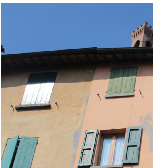
RIDOTTO SPESSORE DELL'ARCHITRAVE IN CORRISPONDENZA DELLA CIMASA MURARIA
