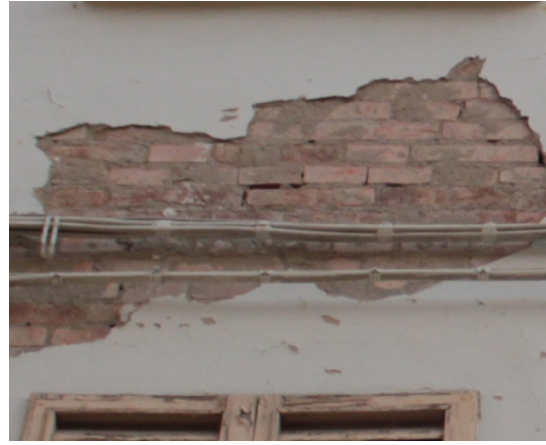
Figura 6 - Murature di Solarolo. A Solarolo non è stato possibile osservare un numero di paramenti sufficiente per poter fare delle considerazioni seppur di livello generale. I campioni osservati sono realizzati in laterizio con disposizione organizzata degli elementi disposti generalmente di testa.
