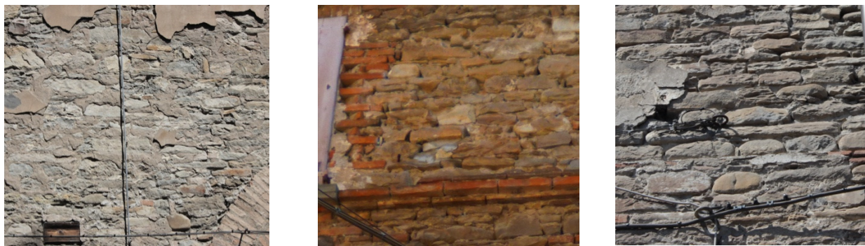
Figura 2 – Murature di Fognano. Le tessiture murarie più frequenti a Fognano sono costituite da pietre sbazzate di forma pressoché regolare, piatte e allungate, con facce piane ben disposte lungo giaciture orizzontali, dimensioni medie dai 30 ai 70 cm. Gli interstizi sono colmati con malta, che in alcuni casi si presenta erosa in corrispondenza del basamento dell'edificio. La presenza di pietre di dimensioni medie consente di ipotizzare con discreta attendibilità una sezione complessivamente compatta. La presenza di laterizi appare sporadica ed in ogni caso associata a tessiture lapidee, in particolare si osserva l'utilizzo di elementi fittili per la realizzazione di rincocciature ripianamenti o cornici.
