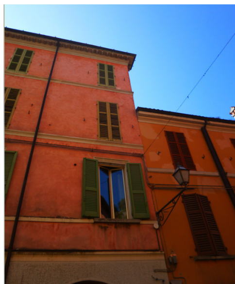
DISALLINEAMENTO DEGLI ORIZZONTAMENTI
