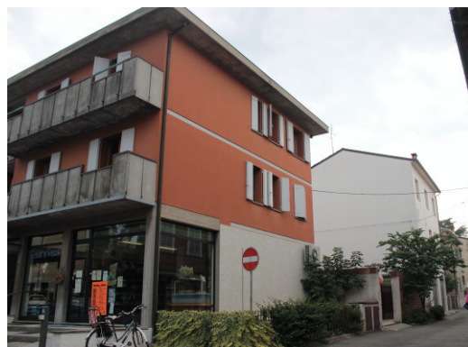
Figura 19 - Solarolo, aggregato SO02, nella foto è inquadrata la testata dell'aggregato costituita da un edificio in cemento armato, individuato nella tavola dal retino "edifici in struttura diversa da quella muraria"
