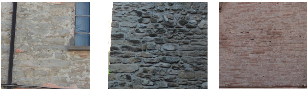
Figura 1 - Murature di Brisighella. Le tessiture murarie più frequenti a Brisighella sono caratterizzate da pietre sbazzate di forma pressoché regolare con facce piane ben disposte lungo giaciture orizzontali, dimensioni medie dai 30 ai 50 cm. Gli interstizi sono colmati con pietre più piccole (10-15 cm) e malta, in alcuni casi erosa in corrispondenza del basamento dell'edificio. La presenza di pietre di medio-grandi dimensioni consente di ipotizzare con discreta attendibilità una sezione compatta con presenza di diatoni disposti a intervalli regolari. Murature di mattoni sembrano essere più rare e localizzate in alcuni palazzi e negli edifici costruiti sopra l'antica cinta muraria.
