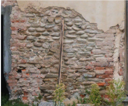
Figura 5 - Muratura di Riolo Terme. Le tessiture murarie più frequenti a Riolo Terme, sono realizzate con ciottoli piatti e allungati ma arrotondati su tutte le fasce. Gli interstizi sono colmati con malta. L'apparecchiatura muraria prevede spesso la presenza di elementi laterizi con funzione di cantonale o di ripianamento.
